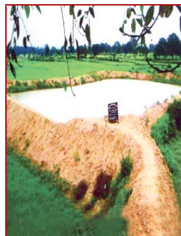
तुरबुल, जिला गुमला में एक तालाब का निर्माण (झारखंड)
